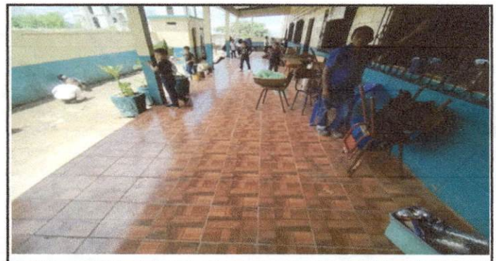
Foto 6: Trabajo terminado SUSTITUCIÓN POR PISO CERÁMICO
