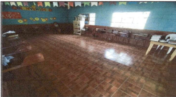
Foto 3: Trabajo terminado SUSTITUCIÓN POR PISO CERÁMICO
