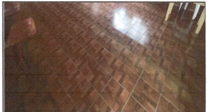
Foto 4: trabajo termino de SUSTITUCIÓN POR PISO CERÁMICO
